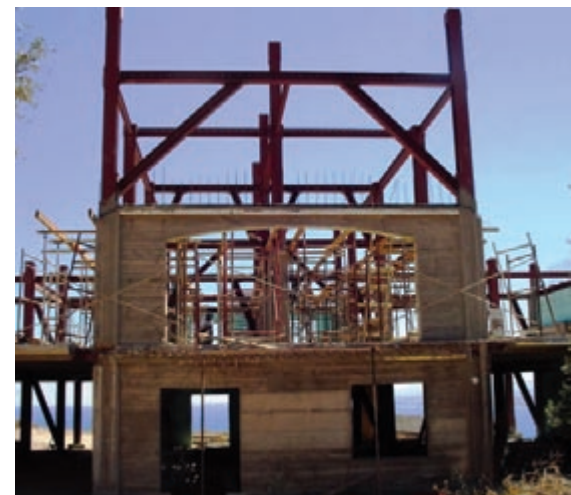
Μικτή κατασκευή οικοδομικού έργου
