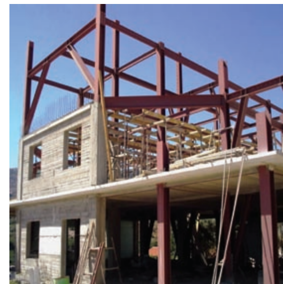
Σχήμα 1β: Μικτή κατασκευή οικοδομικού έργου
