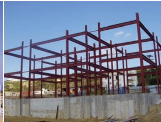
Μικτή κατασκευή οικοδομικού έργου
