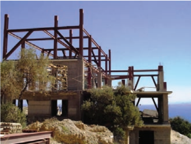
Μικτή κατασκευή οικοδομικού έργου
